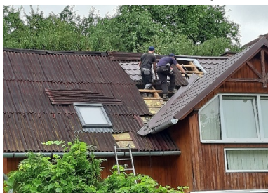
Dach mit alter Wellpappe gedeckt musste ersetzt werden !
